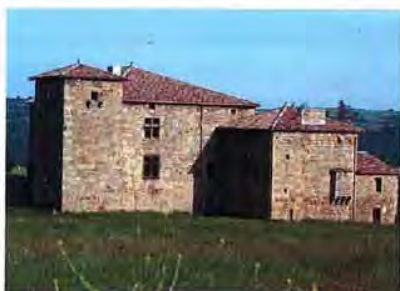
Château de Bellecombe
