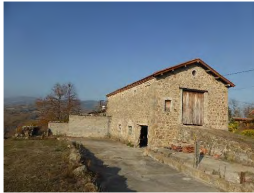
Batiment repéré au nord
