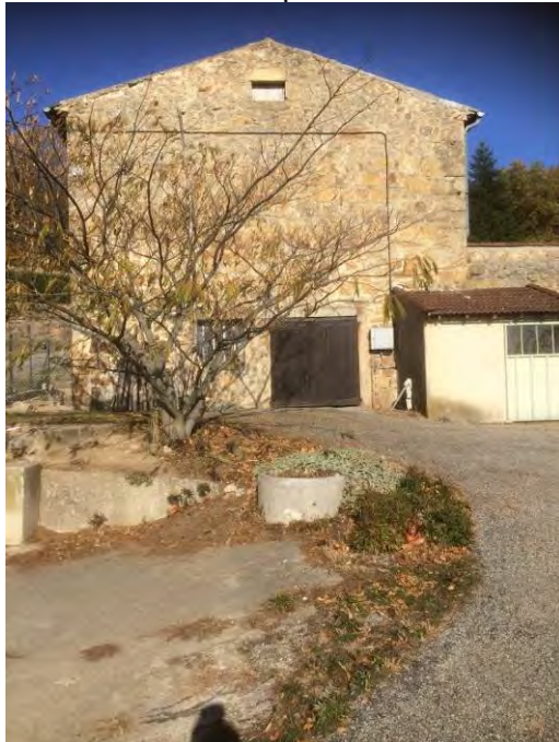
Vue depuis le sud
