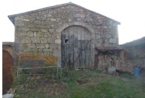
Vue depuis le nord
