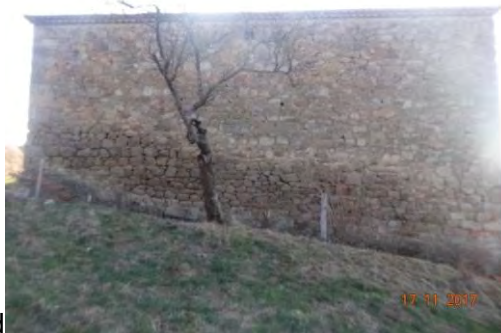
Vue depuis le nord
