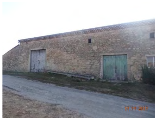
Vue depuis le nord
