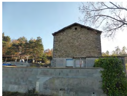
vue depuis le nord
